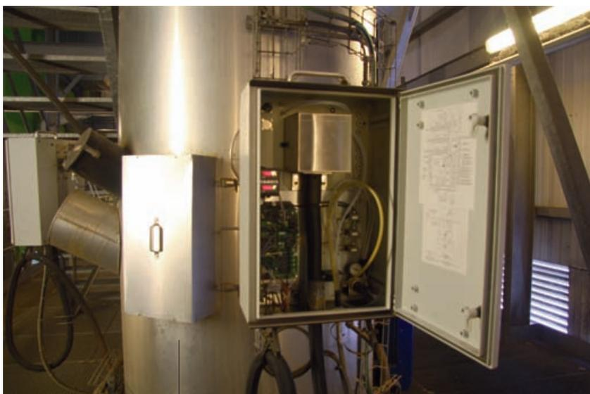
En cheminée, des analyseurs de gaz contrôlent en permanence le bon fonctionnement de l'installation.
